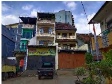
Gambar 5. Kondisi Bangunan yang telah di renovasi (sumber: peneliti, 2020)
