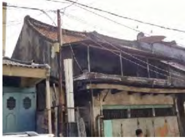
Gambar 4. Kondisi Bangunan Asli (sumber: peneliti, 2020)
