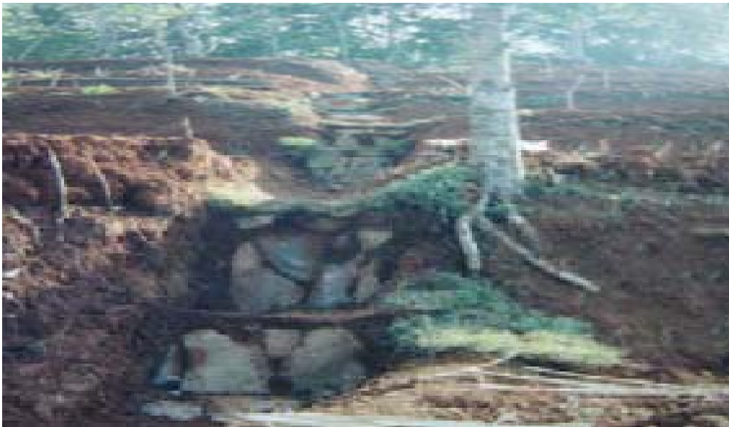
Gambar 3. Saluran pembuangan air (SPA) dengan bangunan terjunan dari batu
