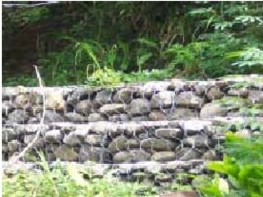
Gambar 1. Bronjong kawat yang dipasang pada tebing lereng
