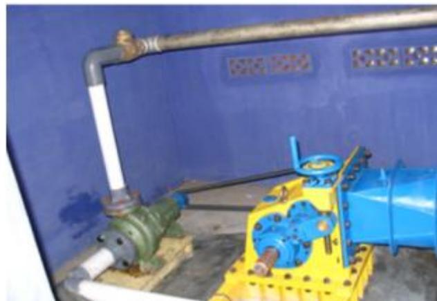
Gambar 15 Hubungan antara turbin dan pompa air
