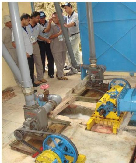
Gambar 17. Hubungan turbin dengan pompa
