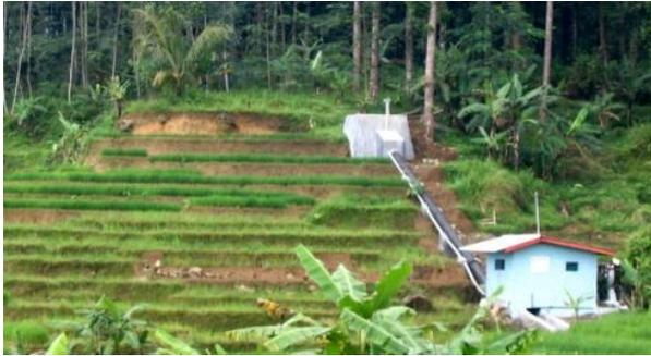
Gambar 11. Pipa pesat PATMH dan PLTMH Gomblang
