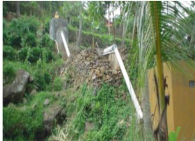
Gambar 14. Pipa pesat pada PATMH Sukarame
