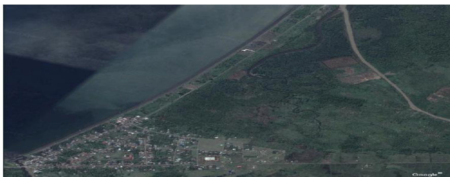
Gambar 4 . Ibukota Kecamatan Bungku Timur ( Desa Kolono ) (Sumber : Google Earth)
