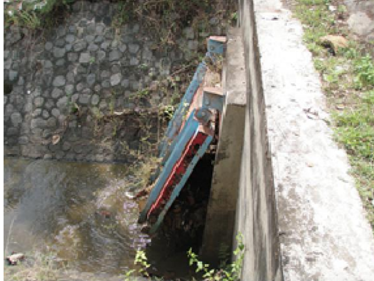
Gambar 6. Pintu air penghubung dengan sungai lama
