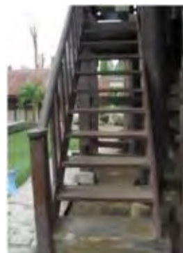
Gambar 9. Tangga pada Rumah Tongkonan (sumber: Nurannisa, 2014)
