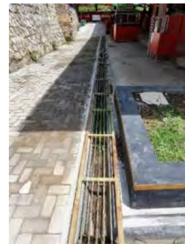
Gambar 8. Kondisi Drainase (sumber: Penulis, 2019)
