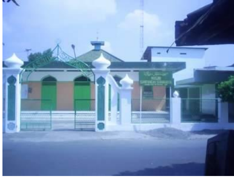
Foto V.4.1. : Masjid Sampangan, Semanggi Sumber : Dokumentasi , 2007
