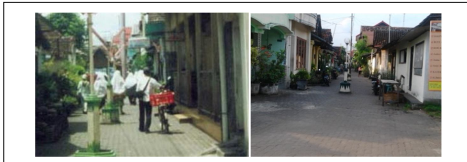
Gambar 3. Pada gang yang lebar, diletakkan lampu penerang ornamenat persis di tengah jalan (sumber : survei peneliti, 2012)
