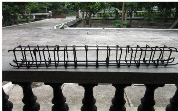
Gambar 1. Penulangan balok beton tanpa kawat galvanis
