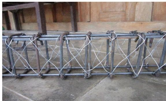
Gambar 2. Penulangan balok beton dengan kawat galvanis
