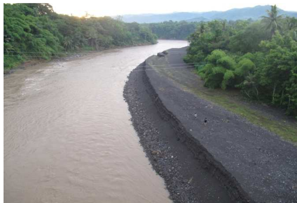
Gambar 2 Sedimentasi yang berlebih pada pias Jembatan Kebon Agung.
