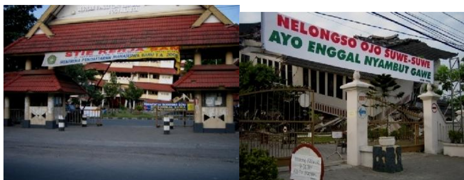
Gambar 01 dan 02: Gempa DIY 27 Juli 2006, dalam gambar ini kerusakan terutama pada struktur bawah (LMB Unika)
