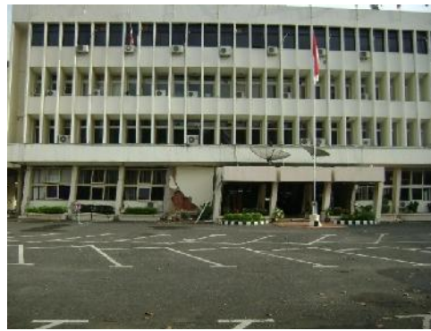
Gambar 03 : akibat Gempa Padang pada gedung pemerintahan (data pribadi)
