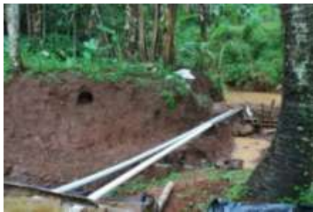
Gambar 9. Bendungan Sederhana Untuk Membuat Terjunan Air 2 Meter
