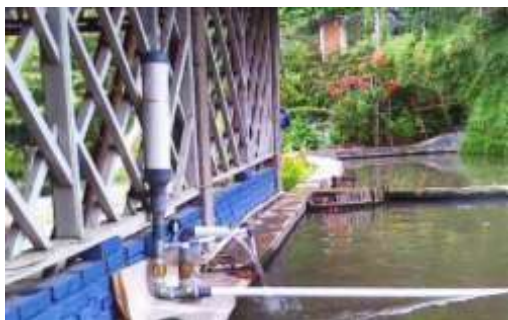
Gambar 1. Pompa hidram ( Hidraulic Ram ) sederhana
