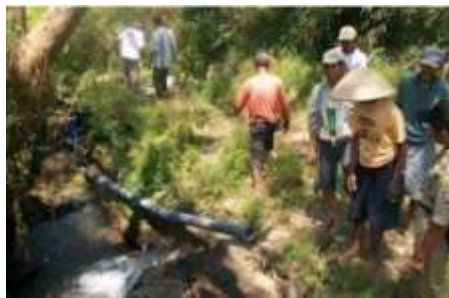
Gambar 10. Instalasi Pipa Pesat Dari Bendungan Ke Hidram, Mitra IbM Aktif Membantu
