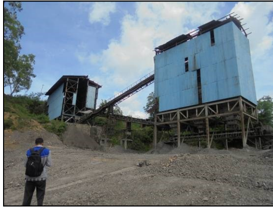
Gambar 3. Proses Pengamatan pada Pabrik Crusher . Sumber : Dokumentasi Penelitian.
