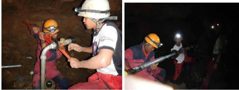
Gambar 4. Kiri: Pelepasan Pompa Submersible Kapasitas 1,5 HP. Kanan: Pemasangan Pompa Submersible Kapasitas 2 HP di Dalam Goa Suruh (Dokumentasi Peneliti, Juni 2014).
