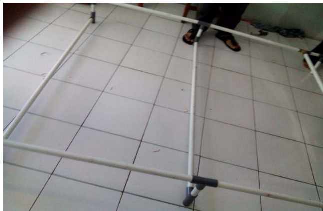
Gambar 1: Pembuatan Rak dari Bahan Pralon
