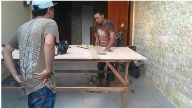
Gambar 8. Proses Pemasangan Badan Lampu
