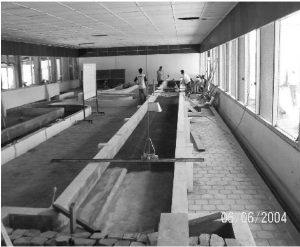
Gambar 1. Foto saluran flume berbentuk majemuk dengan abutmen
