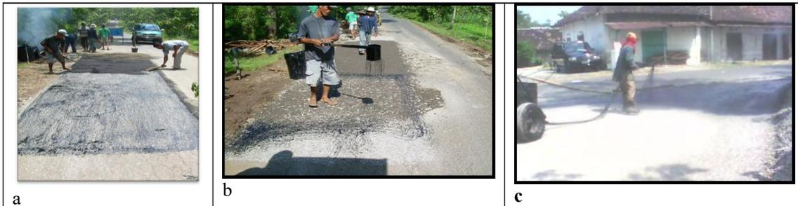
**Gambar 6. Pelaksanaan pekerjaan penanganan rusak retak:** a) penambahan latasir di atas bagian yang retak, b) Penyemprotan *tack coat* secara manual, c) penyemprotan dengan alat sesuai Bina Marga 1987.
