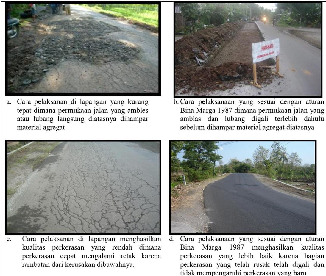
**Gambar 9. Perbandingan cara dan kualitas hasil penanganan di lapangan dan Bina marga 1987 untuk jenis kerusakan ambles dan lubang**
