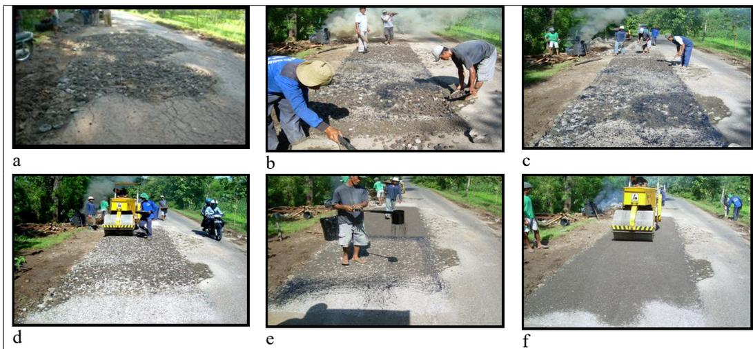
**Gambar 8. Pelaksanaan pekerjaan penanganan lubang:** a) Pentupan lubang dengan lapis pondasi Telford; b) Pekerjaan penghamparan batu 3-5 cm diatas pondasi Telford; c) Penghamparan batu pengunci 2-3 cm; d) Pemadatan lapis batu 3-5 cm dan 2-3 cm; e) Pekerjaan penyemprotan lapis pasir yang kedua; f) Pemadatan akhir setelah penghamparan lapisan pasir.
