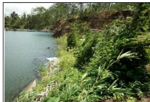
Gambar 7. Kondisi eksisting bio-talud
