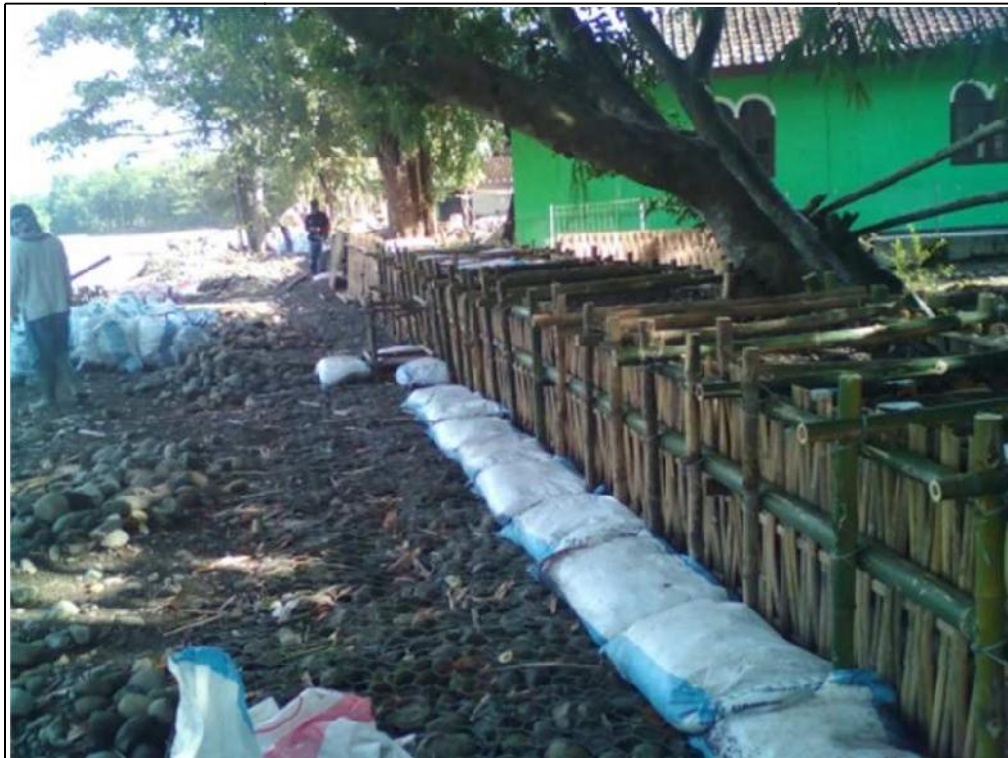
Gambar 2. Bio-Engineering Tipe 1 (Bio-Tanggul), lokasi di Sungai Cijangkelok Desa Citenjo Kecamatan Cibingbin Kabupaten Kuningan
