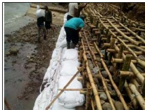
Gambar 6. Kondisi awal konstruksi bio-talud terpasang
