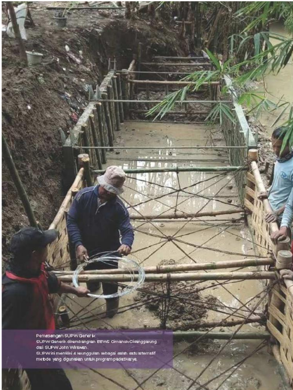
Gambar 8. Pemasangan SUPW Generik tipe medium dan tipe ekonomi berwawasan lingkungan untuk perkuatan tebing sungai
