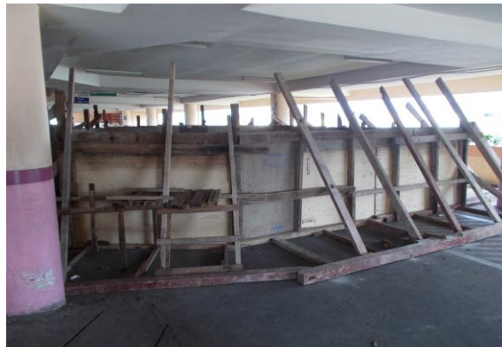
Gambar 10. Pemasangan bekisting untuk Loading Test
