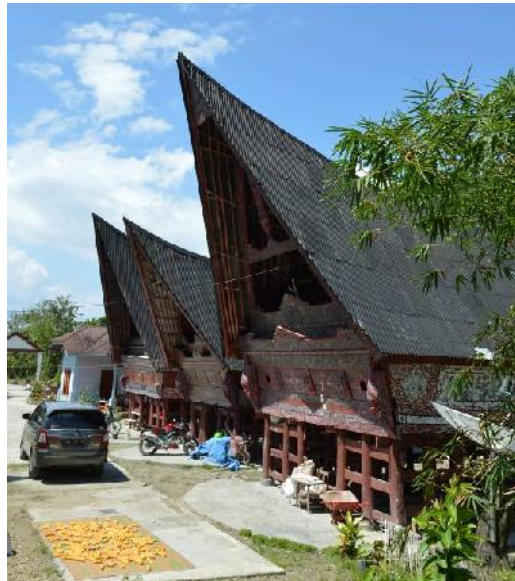
Gambar 1. Rumah Bolon di Dusun 2 yang telah direvitalisasi.
