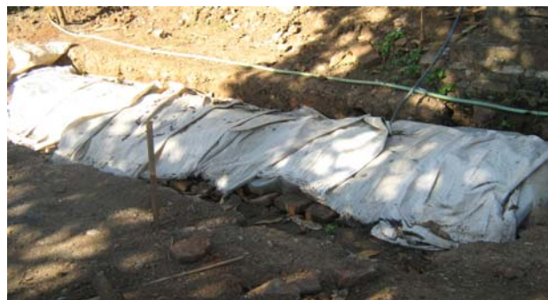
Gambar 3. Foto Bak Digester dari Kantung Plastik polyethylene
