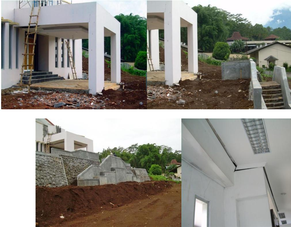
**Gambar 1.** Pondasi kanopi mengalami pergerakan lateral searah pergeseran talud dan pergerakan vertikal searah gravitasi dapat dilihat secara visual dari dalam maupun luar gedung.
