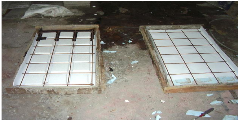
Gambar 2. Pencetakan pelat beton
