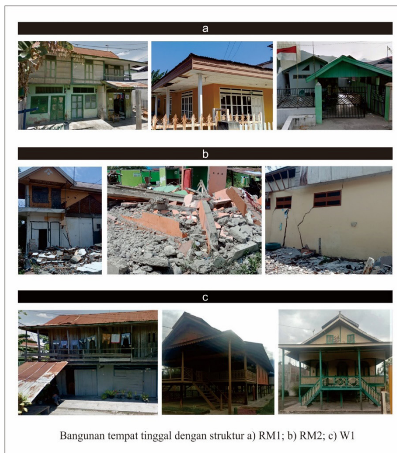
Gambar 2. Perbandingan Kerusakan Bangunan Tempat Tinggal berdasarkan Struktur Bangunan Sumber: Pengolahan Data Primer, 2019
