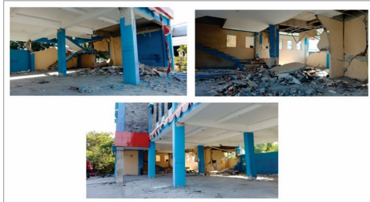
Gambar 15. Gambar Kantor Pemadam Kebakaran hasil survei lapangan Sumber: Penulis, 2019
