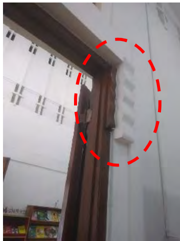
Gambar 12. Pintu (sumber: Dokumen Pribadi, 2019)
