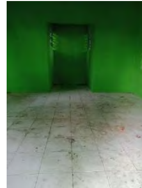
Gambar 14. Kondisi Mushola (sumber: Dokumentasi Pribadi, 2019)
