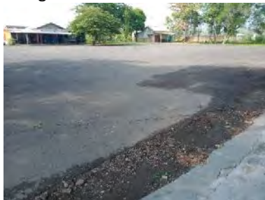
Gambar 12. Perkerasan di Kantong Parkir (sumber: Dokumentasi Pribadi, 2019)
