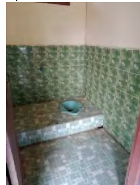
Gambar 13. Kondisi Toilet (sumber: Dokumentasi Pribadi, 2019)
