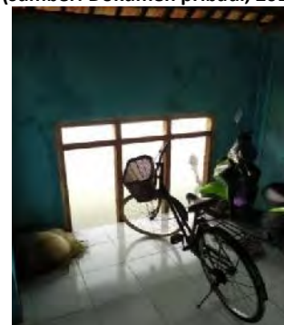
Gambar 8. Keadaan Rumah Terdampak Rob (sumber: Dokumen pribadi, 2019)
