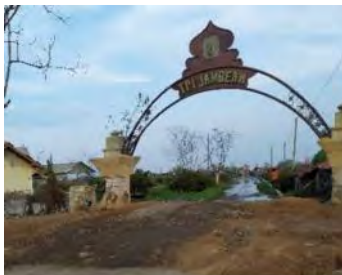
Gambar 11. Gapura Terdampak Rob (sumber: Dokumen pribadi, 2019)
