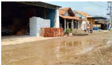
Gambar 17. Jalan Rusak karena Rob (sumber: Dokumen pribadi, 2019)
