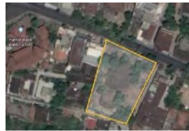
Gambar 4. Lokasi Proyek Hotel Acacia Solo
