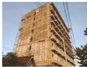
Gambar 6. Kondisi Proyek Pembangunan Hotel Acacia Solo
