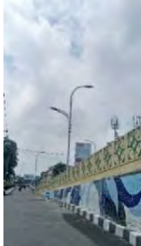
Gambar 6. Lampu Penerangan Jalan (sumber: Dokumentasi pribadi, 2019)
