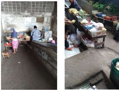
Gambar 5 Keadaan ramp 1 Gambar 6 Keadaan ramp
