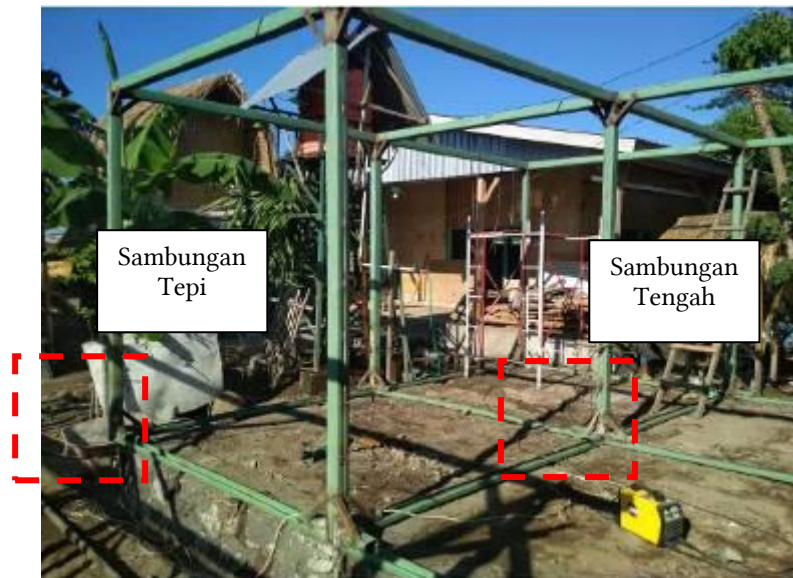
Gambar 14. Bangunan RISBA (Bimbingan Teknis Penerapan Teknologi Rumah Tahan Gempa Mataram, NTB, 2019)
