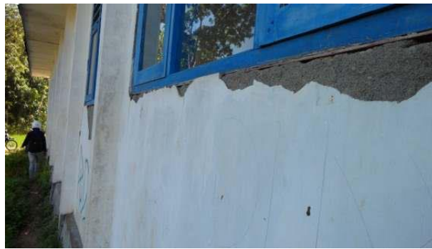
Gambar 3. Kondisi Eksisting Bangunan
