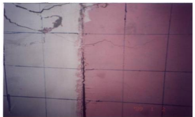
Gambar 8. Belahan pada batas sambungan
