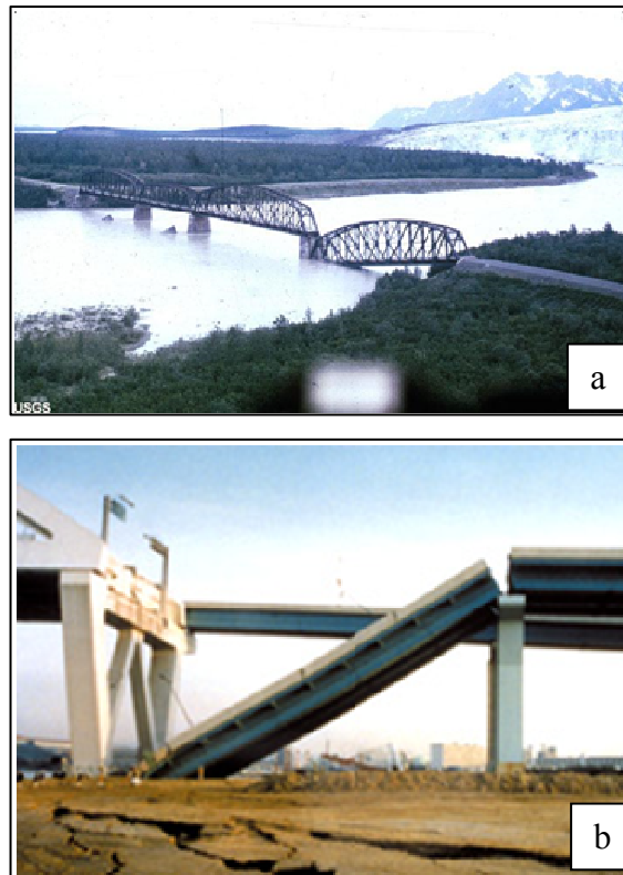
Gambar 2. Terpisahnya bentang jembatan dari perletakannya: (a) Gempa Alaska 1964; (b) Gempa Kobe 1995
