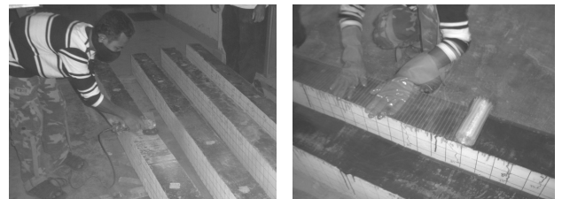
Gambar 7. Penempelan lembaran serat gelas
