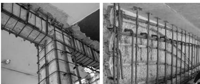
Gambar 2. Metode perkuatan elemen struktur
