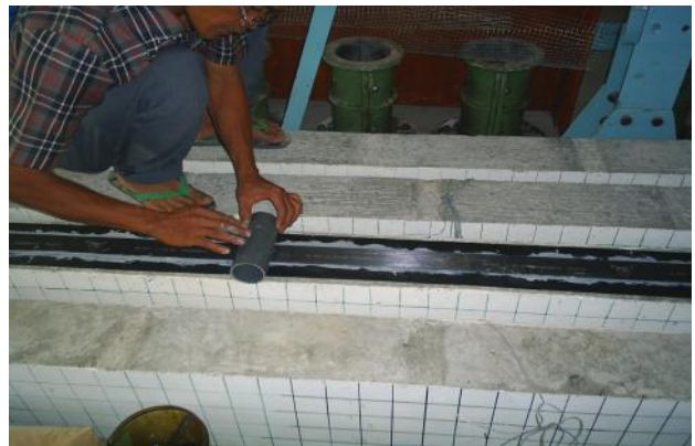
Gambar 7. Pemasangan CFRP pada balok
