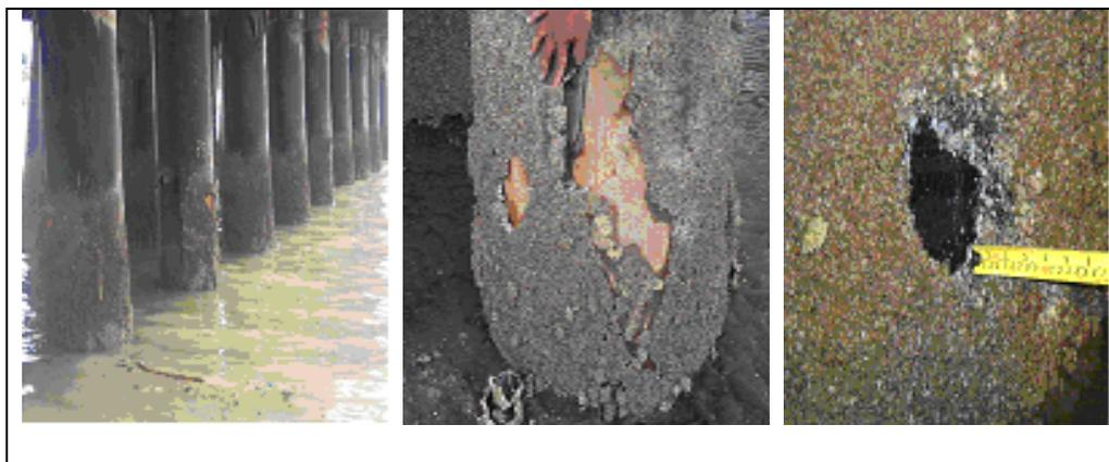
Gambar 1. Biota laut menyerang konstruksi pondasi tiang pancang jembatan (mengakibatkan kerusakan pada struktur beton bertulang)
