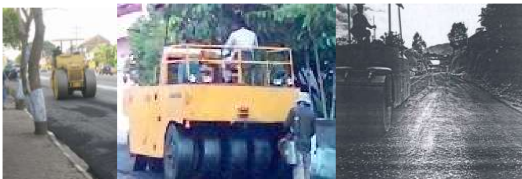
Gambar 1. Alat pemadat di lapangan yang terdiri dari Three Wheel Roller (paling kiri), Pneumatic Tire Roller (tengah), dan Tandem Roller (paling kanan)
