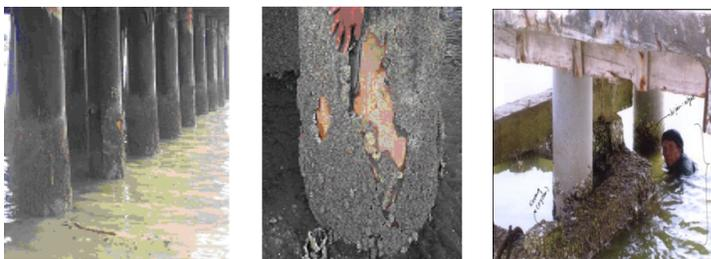
Gambar 1. Biota laut menyerang konstruksi pondasi tiang pancang jembatan Sumber : Dokumentasi kunjungan lapangan / lokasi jembatan Suramadu (2005).
