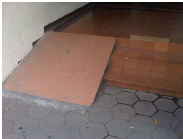
Gambar 3 . Ramp yang sangat curam pada area drop off gedung utama perkuliahan kampus UKDW. Foto: Parmonangan Manurung
