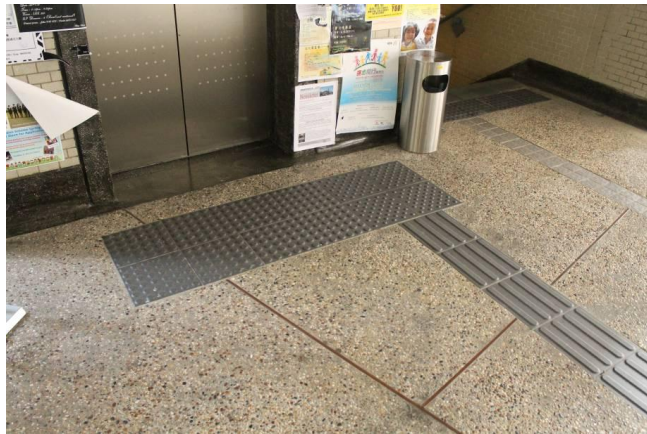
Gambar 7 . Guiding Block menghubungkan semua fasilitas termasuk elevator dan tangga. Foto: Parmonangan Manurung
