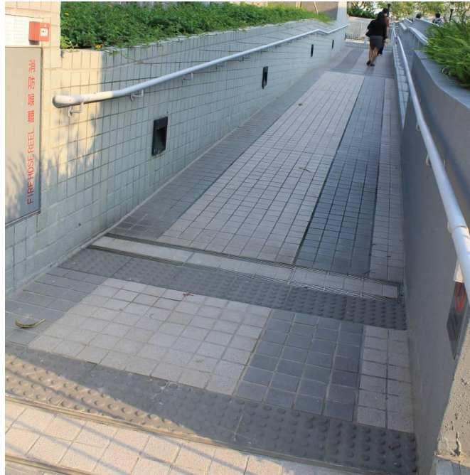
Gambar 9. Ramp sebagai sirkulasi vertikal, dirancang cukup landai dan dilengkapi handrail serta guiding block sehingga dapat digunakan
