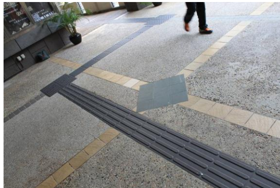
Gambar 5 . Guiding Block yang menjadi pengarah dan pemberi informasi bagi tuna netra di lingkungan kampus Lingnan University .
