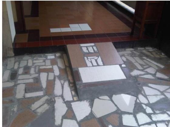
Gambar 4 . Ramp pada setiap jembatan penghubung antar gedung di kampus UKDW. Foto: Parmonangan Manurung
