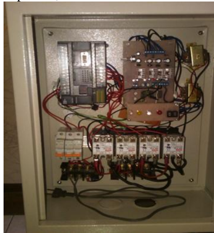
Gambar 4. Sistem kontrol PLTPH
