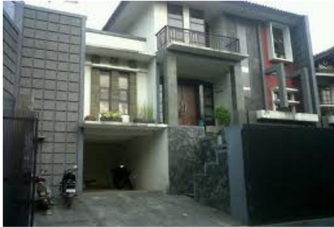
**Gambar 1.** Halaman Rumah tertutup lapisan perkerasan kedap air.
