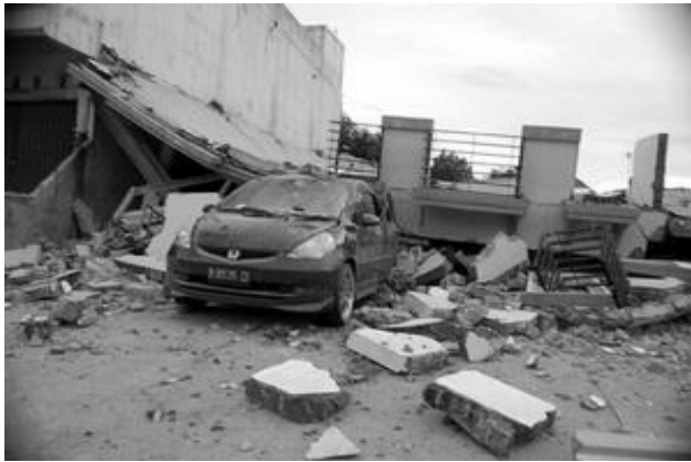
Gambar 1. Kerusakan bangunan gedung akibat gempa tektonik di Padang, Sumatera Barat, Rabu 30 September 2009 (Sumber : kompas.com)
