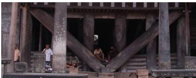
**Gambar 1.** Pondasi umpak dan sistem struktur pada rumah Nias
