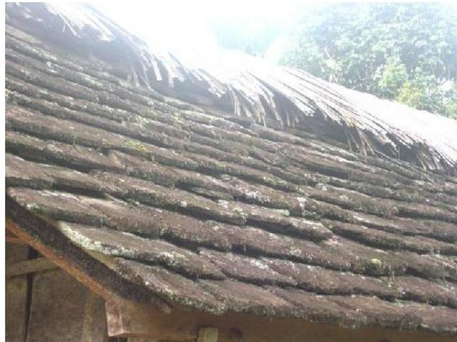
**Gambar 3.** Sistem struktur dan material atap batu pada rumah Tongkonan di Toraja, Sulawesi Selatan
