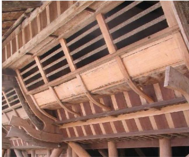
**Gambar 4.** Bukaan pada rumah Nias berperan dalam mengoptimalkan pencahayaan alami dan penghawaan alami, sebuah pendekatan arsitektur hemat energi dan berkelanjutan
