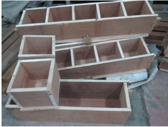
Gambar IV-9 Begisting/ cetakan beton
