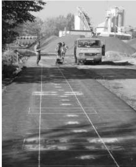
Gambar 2.8. Garis-garis di Tengah Perkerasan yang Berjarak 1 m Direncanakan untuk Sampel Pengujian di Laboratorium (Grabowski and Pozarycki, 2008)
