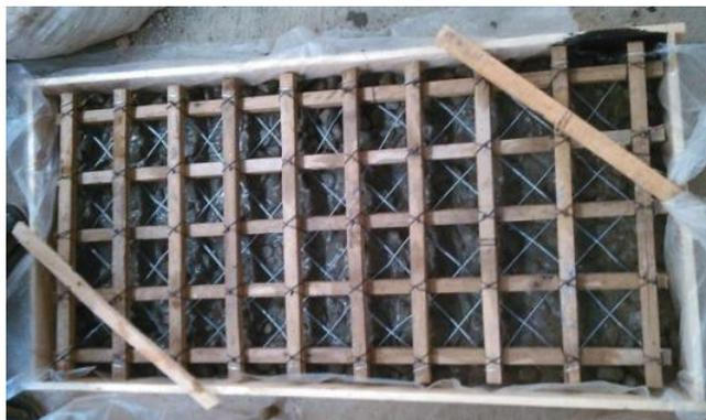
**Gambar 1.** Bentuk penulangan pelat dengan bamboo laminasi dan kawat galvanis menyilang
