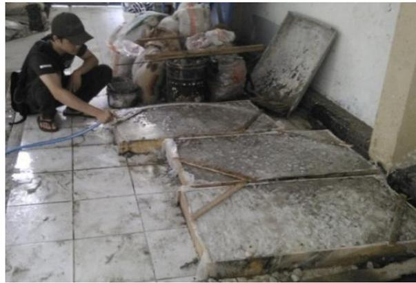
**Gambar 2.** Perawatan pelat beton uji setelah dicor.
